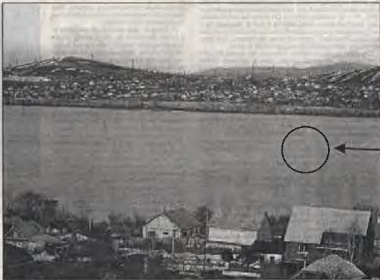
Вот в этом самом месте идут сейчас строительные работы.
